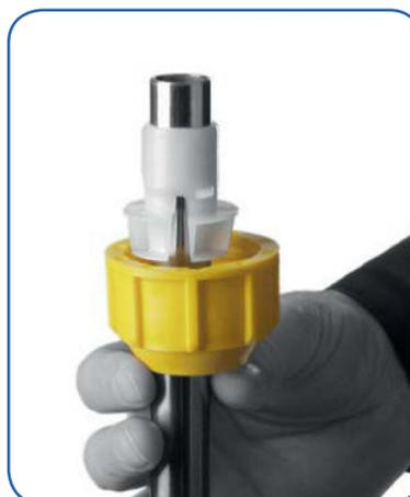
PASO 8 : El adaptador blanco se pone en el tubo de agua. Hay varios modelos de adaptadores para diferentes diámetros de tubos.
