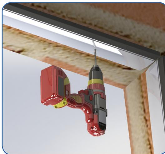
Fig. 07. Agujeros en el soporte para anclarlo a la pared.
