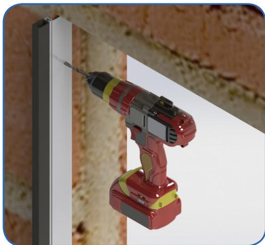
Fig. 06. Agujeros en el soporte para anclarlo a la pared.
