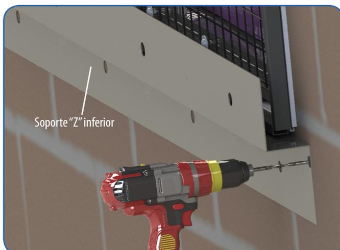
**Fig. 13.** Colocación del soporte "Z" inferior.
