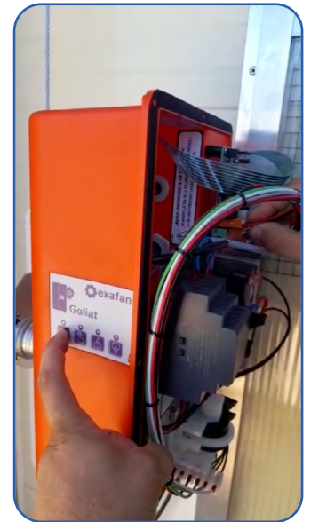
3º. Conectar los cables de alimentación.
