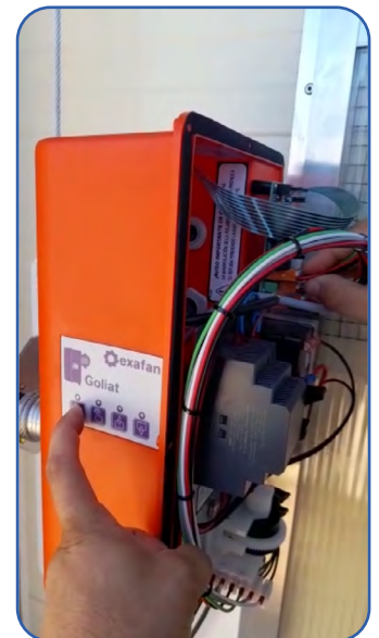
3º. Conectar los cables de alimentación.
